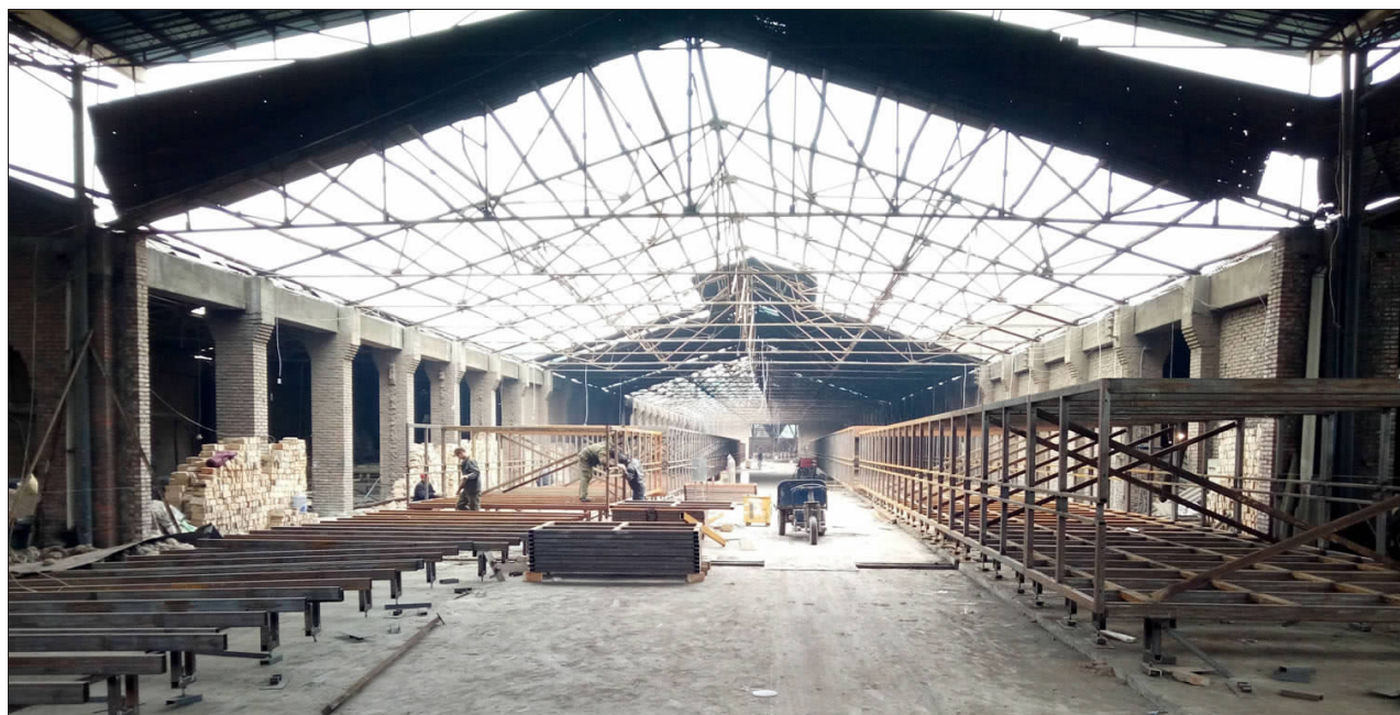
夹江产区区内受环保高压而拆除重新建线现场。
