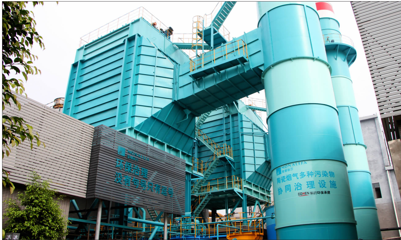
科行环保在蒙娜丽莎建立的“陶瓷烟气多种污染物协同治理设施”。
