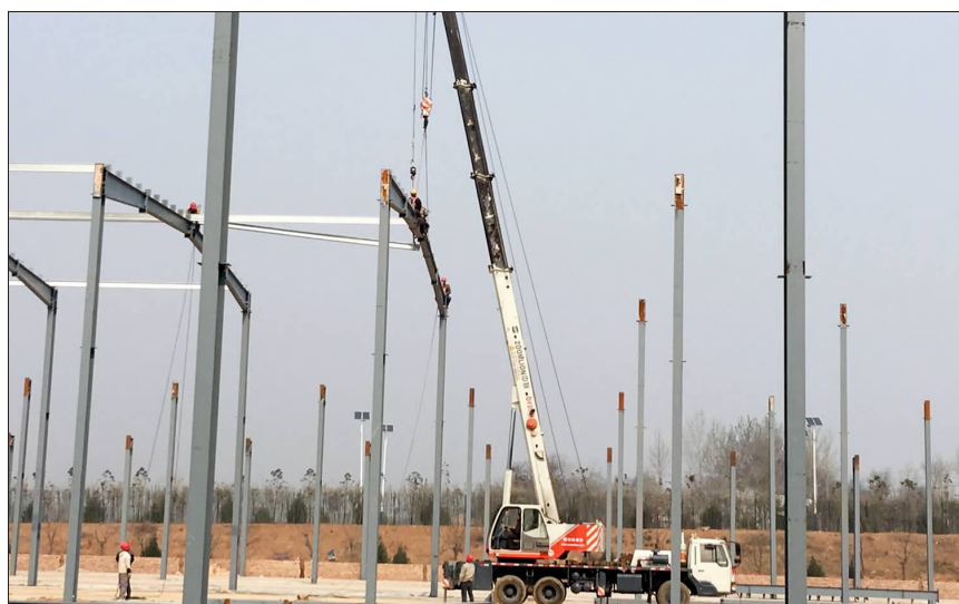
山西金世家陶瓷正在建设中的瓷片生产线。
